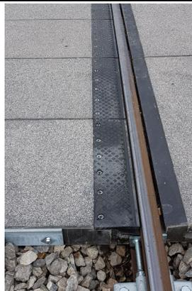
7. Innensechskantloch mit Füllmaterial ADHESEAL oder Gleichwertigem ausfüllen (dient der Schraubensicherung und zum Schutz vor Verschmutzungen).
