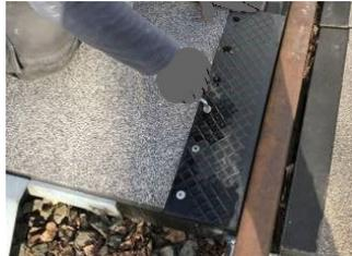
6. Rillenfüller mit den mitgelieferten Schrauben montieren. Schrauben mit Anti Seize Spray Spezialpaste oder Gleichwertigem besprühen. Pro Rillenfüller alle sechs Schrauben per Hand mit Innensechskantschlüssel (Inbus) eindrehen
