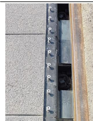
4. Sollte das Gummiprofile PIO-F im Bereich der Kleineisenaussparung nicht offen sein, muss dieser Bereich bei der Montage ausgeschnitten werden. Achtung: Vor Schnittverletzungen schützen (persönliche Schutzausrüstung verwenden!)
