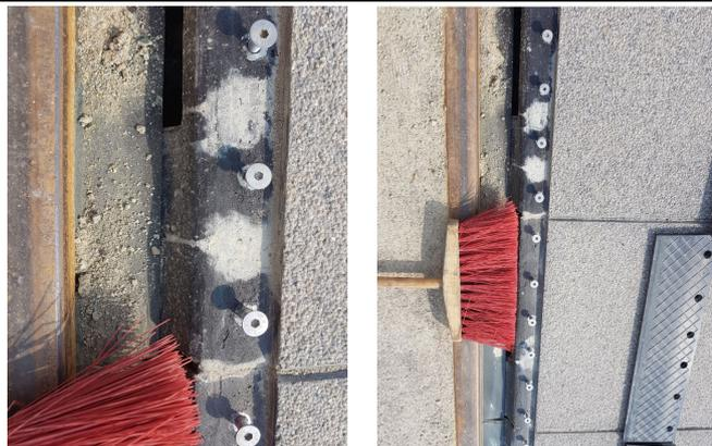
3. Anschließend die Schrauben sofort wieder in die Ösenmuffen eindrehen, damit die Gewinde der Ösenmuffen vor Verschmutzungen und Beschädigungen geschützt sind.
