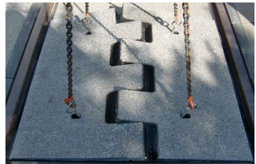
Foto 4 Die beiden Platten werden in Montageposition gebracht
