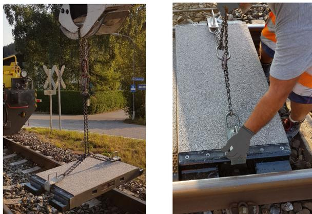
4. BODAN2-Innenplatten für Rillenfüller FWC werden wie Standard-BODAN2-Innenplatten (siehe BODAN-Einbauanleitung) eingebaut. BODAN Standard-Werkzeug (S-Haken, A-Haken, O-Ring, Kettengehänge, usw.) verwenden.
