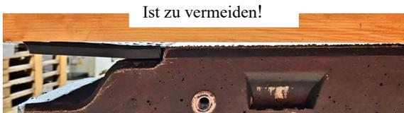
8. Beim Einlegen des BODAN-Rillenfüller FWC in die Rillenfüllerplatte ist sicherzustellen, dass der Metalldistanzring auf der Unterseite des BODAN-Rillenfüller FWC korrekt positioniert ist. Fehlt der Metalldistanzring (aus irgendeinem Grund), darf der BODAN-Rillenfüller FWC nicht montiert werden. In diesem Fall muss ein Metalldistanzring wieder eingelegt werden.
