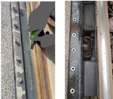
7. Falls das Einfedern des BODAN-Rillenfüller FWC aufgrund einer reduzierten Spurrillentiefe (4 mm) z.B. bei abgefahrenen Schienenköpfen nicht mehr vollständig möglich sein sollte, kann die Fahne (4 mm) des PIO-F mit einem Cuttermesser entfernt werden. (Diese Verringerung der Spurrillentiefe kann durch Abnutzung der Schiene oder im Bereich von Schienenstößen auftreten). Hinweis: Schützen Sie sich vor Schnittverletzungen, in dem Sie persönliche Schutzausrüstung tragen!
