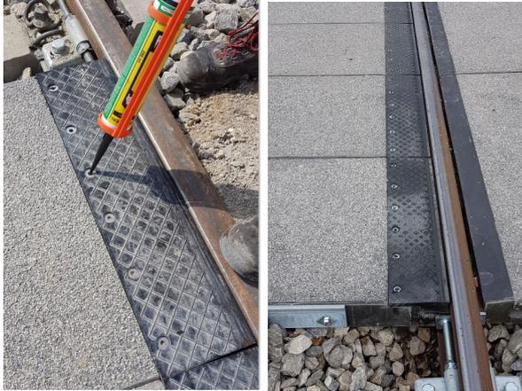
12. Zum Schutz des Innensechskants der Zylinderkopfschraube vor Verschmutzung, Beschädigungen durch das Eindringen von Fremdkörpern (z.B. Sand, Kies usw.) sowie vor schädlichen Einwirkungen Dritter wird empfohlen, den 7 mm Innensechskant mit einem geeigneten Füllmaterial, wie beispielsweise ADHESEAL oder einem gleichwertigen Produkt, auszufüllen.
