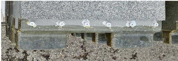
6. Das Gewinde der Ösenmuffen ist stets vor Verunreinigungen und Beschädigungen zu schützen. Insbesondere ist darauf zu achten, dass während des Eindrehens der Zylinderkopfschrauben mit einem Innensechskant von 7 mm geeignete Maßnahmen ergriffen werden, um eine Beschädigung des Gewindes zu vermeiden.
