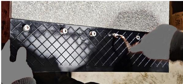
9. Montieren Sie den BODAN- Rillenfüller mit den mitgelieferten Zylinderkopfschrauben mit 7 mm Innensechskant und eingelegten Fächerscheiben M10 mm. Diese können vor der Montage mit einem speziellen Anti-Seize-Spray oder einem gleichwertigen Produkt behandelt werden.
